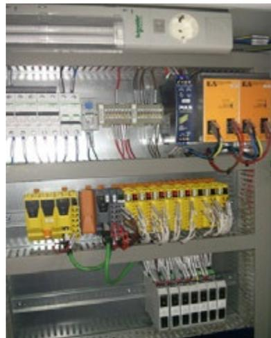
Implementierung eines openSAFETY Konzeptes bei Suplacu de Barcau der OMV PETROM E&P
